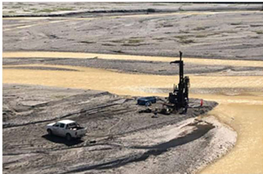
Construcción del Puente Sacambaya
