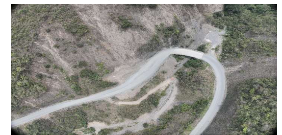
Carretera Unduavi Chulumani (Ejecución Tramos 2A Y 2B)
