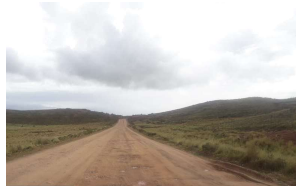
Carretera Botijlaca - Charaña, Tramo I: Botijlaca - Caquiaviri
