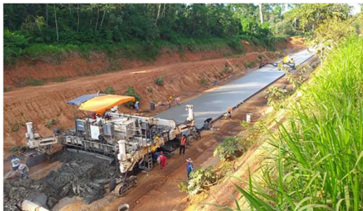
Const. Tramo IIB: Puerto Rico – Puerto Madre De Dios (El Sena)
