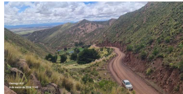
Construcción y Asfaltado de La Joya - Chuquichambi, Huayllamarca - Totora y Los Puentes Vehiculares La Joya y Crucero en la RVF 031
