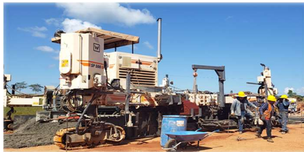
Const. Carretera Porvenir – Puerto Rico; Tramo IA: Porvenir – San Miguel
