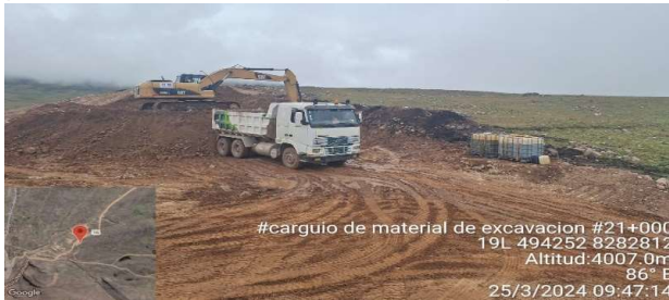
Carretera Escoma – Charazani: Tramo I Escoma Pacobamba
