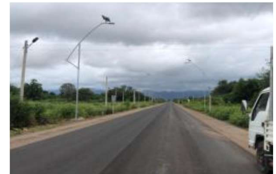
Tramo Carretero Villamontes - La Vertiente – Palo Marcado
