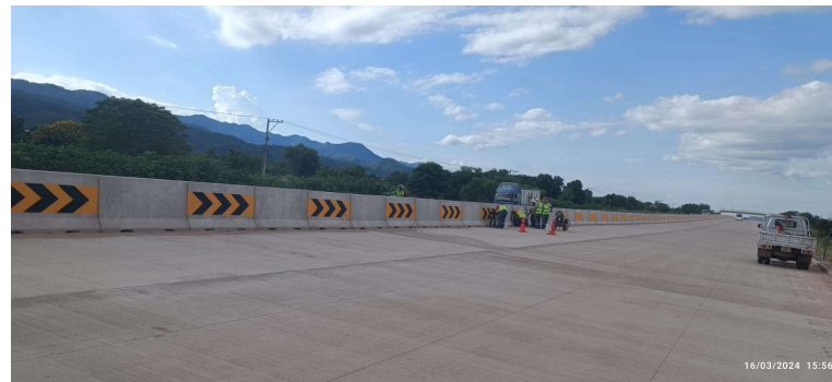
Tramo Carretero Doble Vía Yacuiba – Campo Pajoso – Fase I
