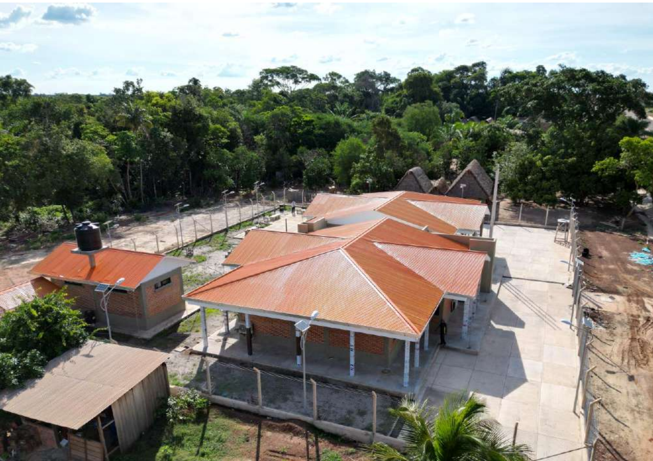
Construcción del Centro de Capacitación Australia
