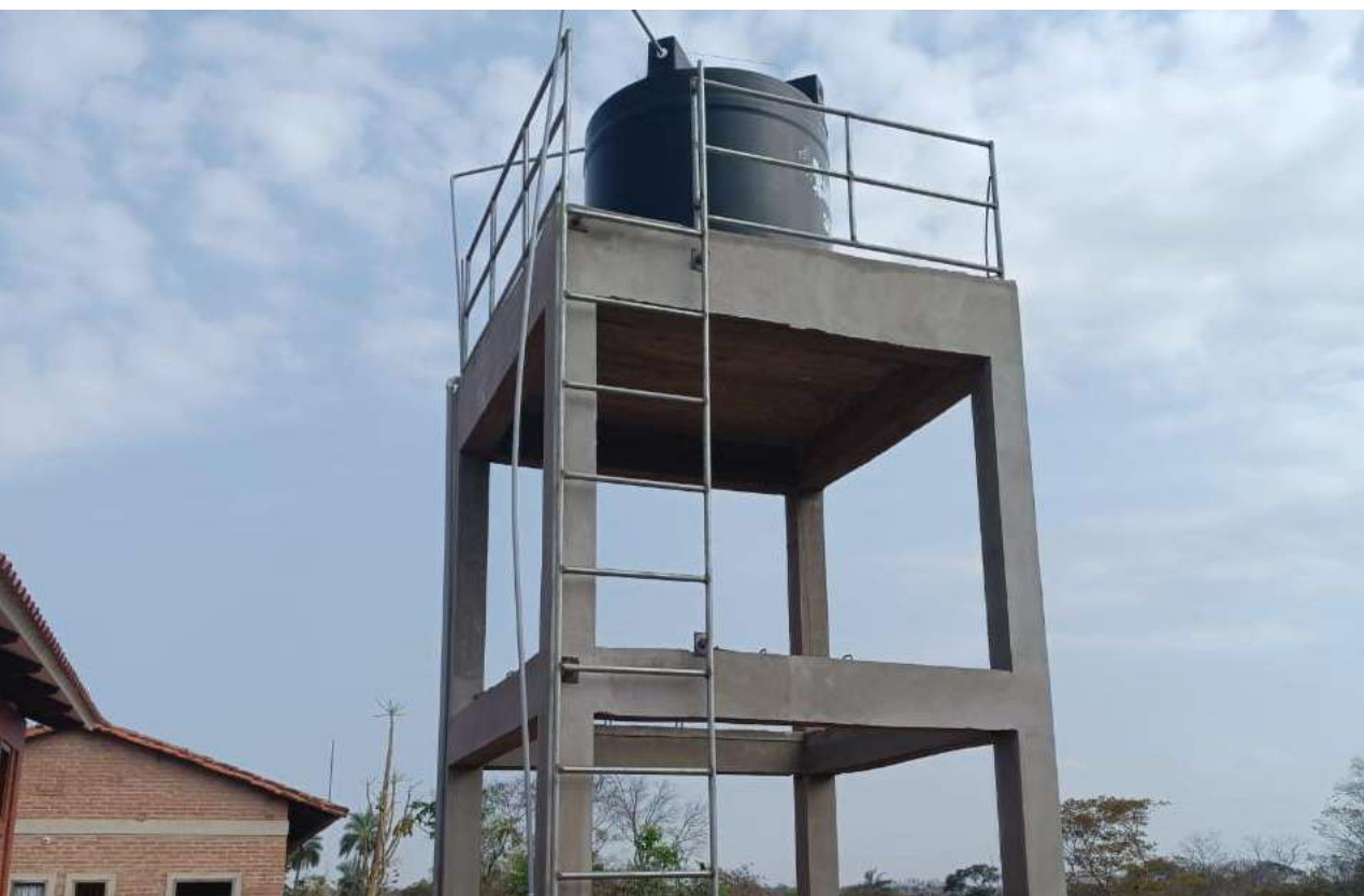
Tanque de agua
