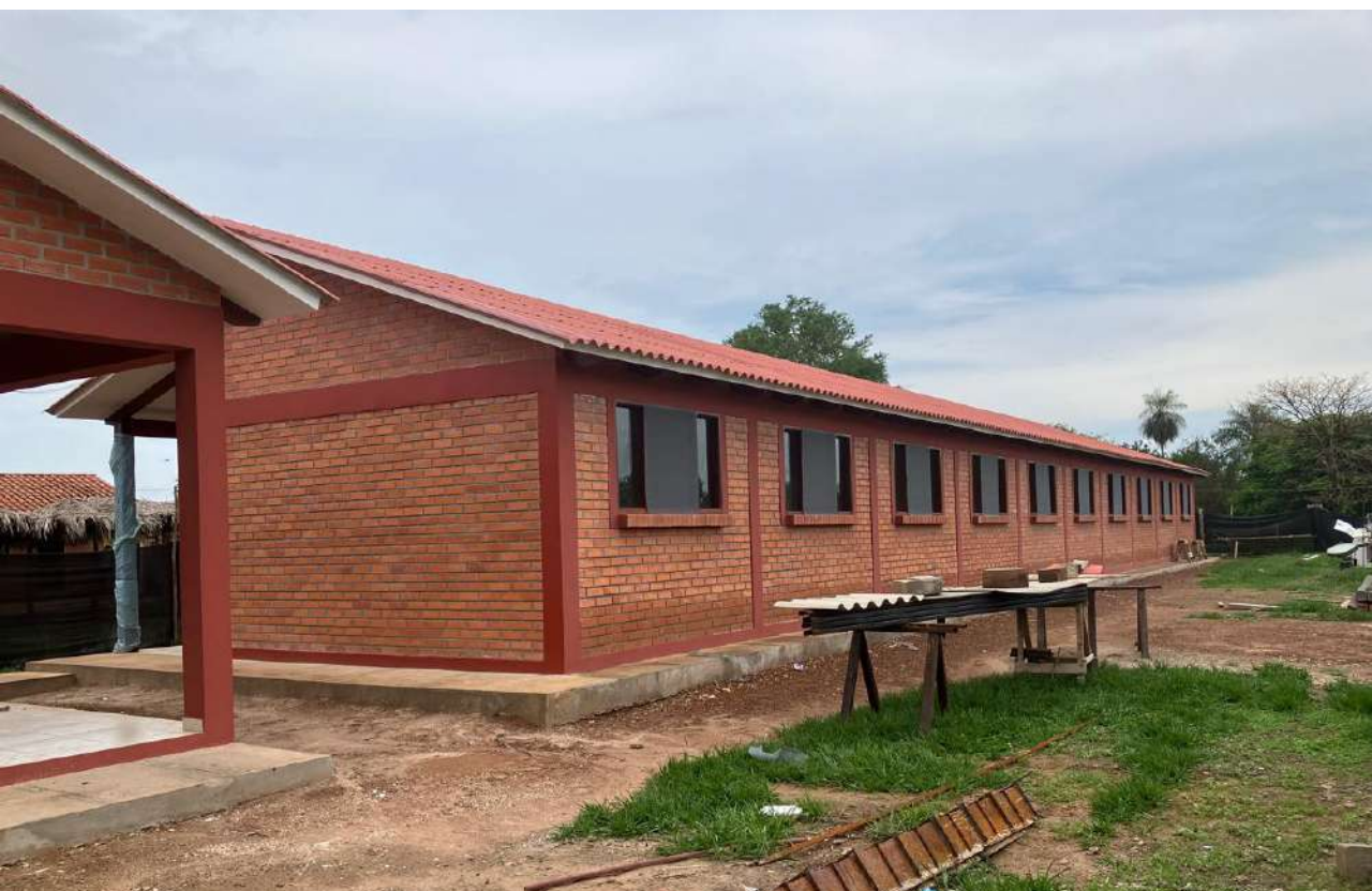
Construcción de bloque de aulas
