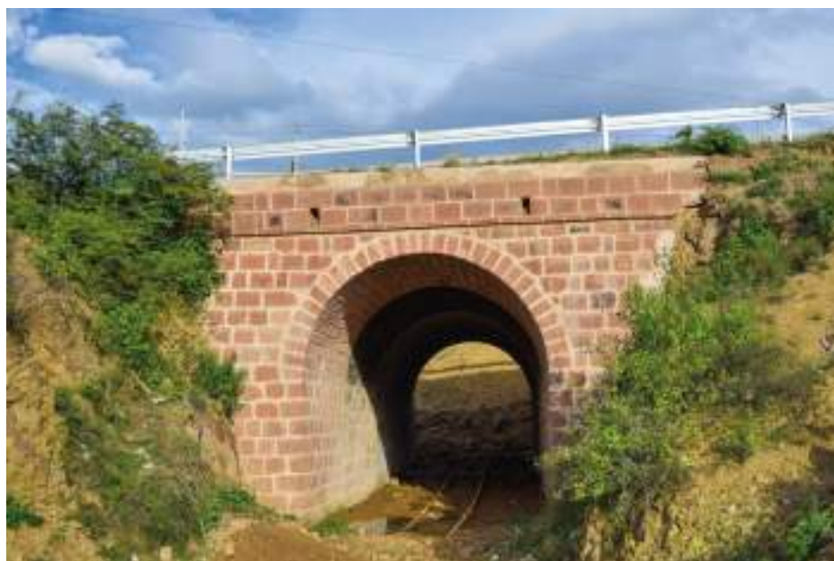
Figura 42 Panorámicas del interior y exterior de la bóveda.
