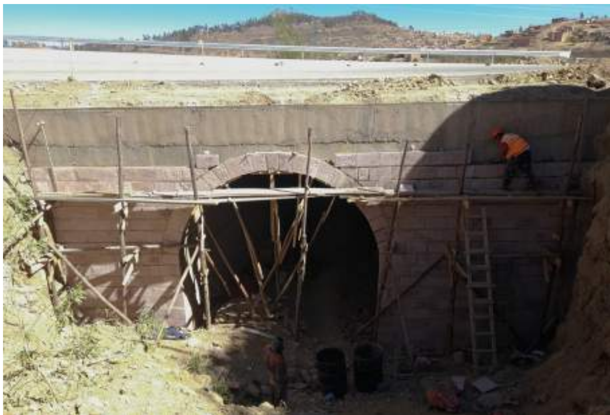
Figura 41 Trabajos de construcción de la Doble Vía Sucre-Yamparáez
