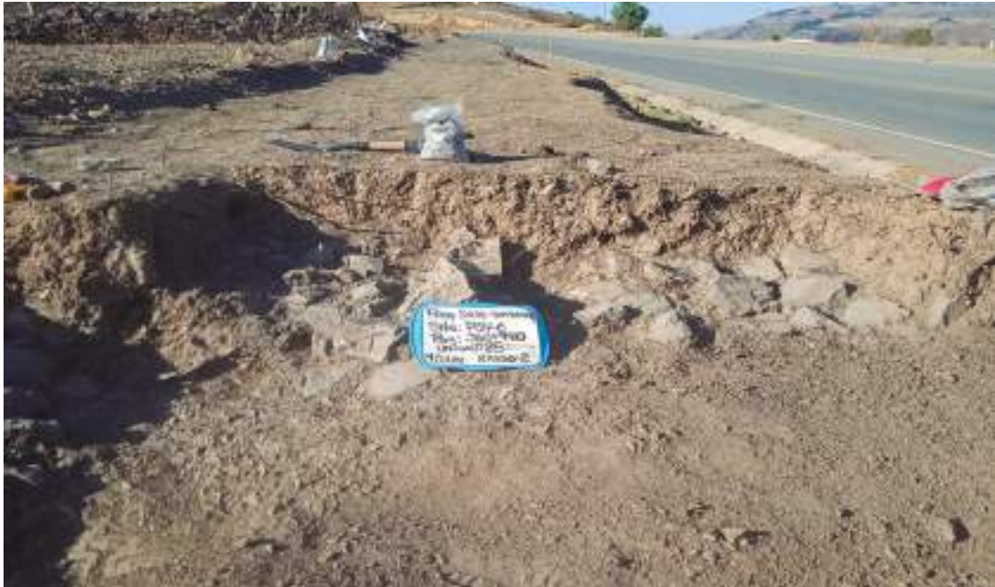
Figura 102 Presencia de piedras y fragmentos de cerámica que componen el muro, Unidad 25, Sitio 6.
