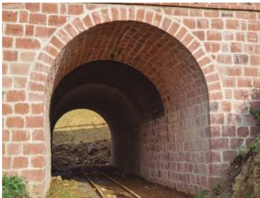
Figura 162 Vista de la fachada Oeste antes de la intervención
