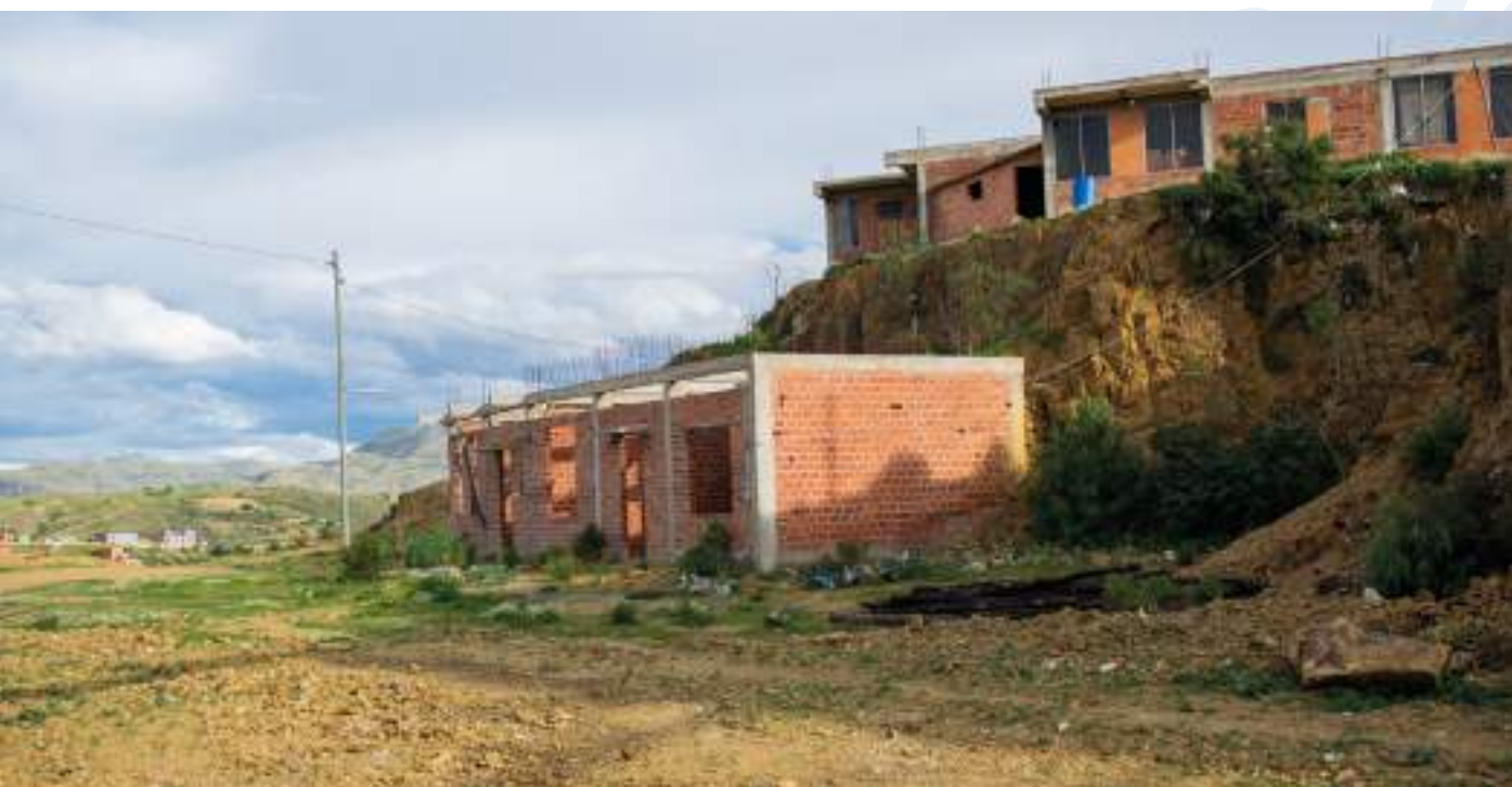
Figura 35 Panorámica del entorno Oeste, donde se emplaza la bóveda.
