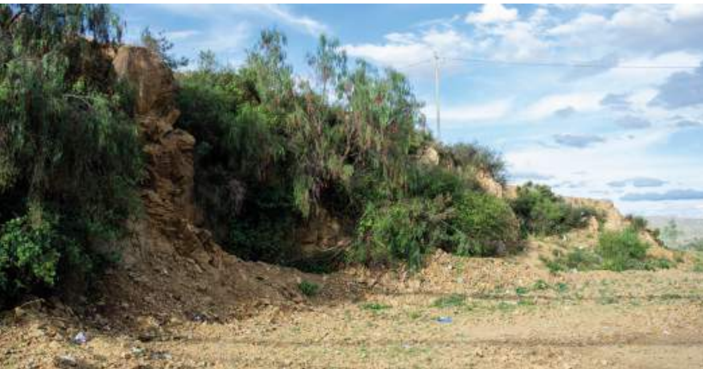
Figura 34 Panorámica del entorno Este, donde se emplaza la bóveda
