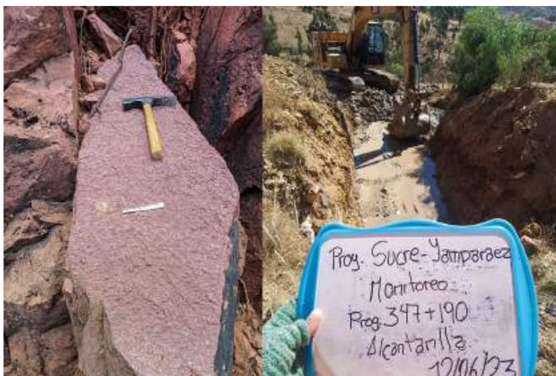
Figura 31 Trabajo de monitoreo durante la ejecución de la obra.
