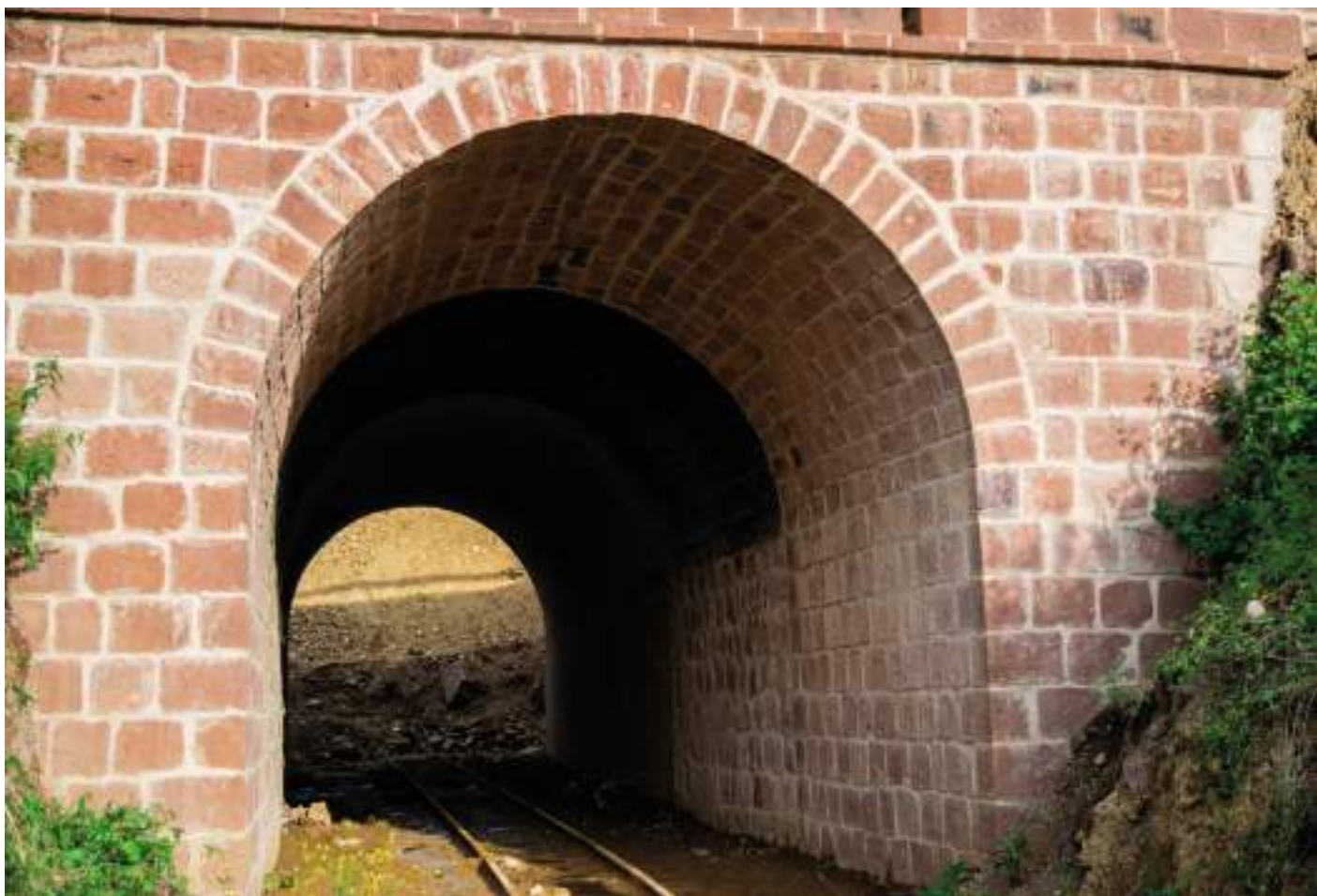
Figura 36 Fotografía del ingreso Este de la bóveda.
