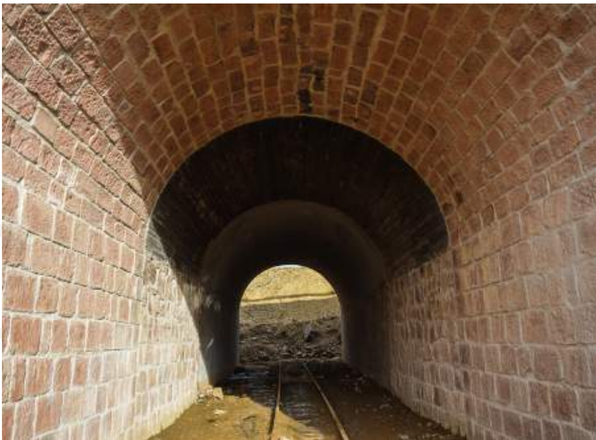
Figura 46 Fotografía del interior de la bóveda
