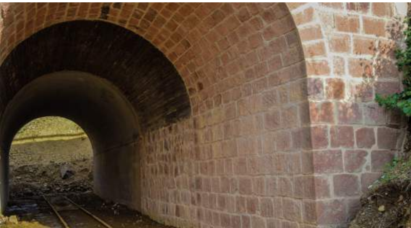
Figura 37 Fotografía del ingreso Oeste de la bóveda.
