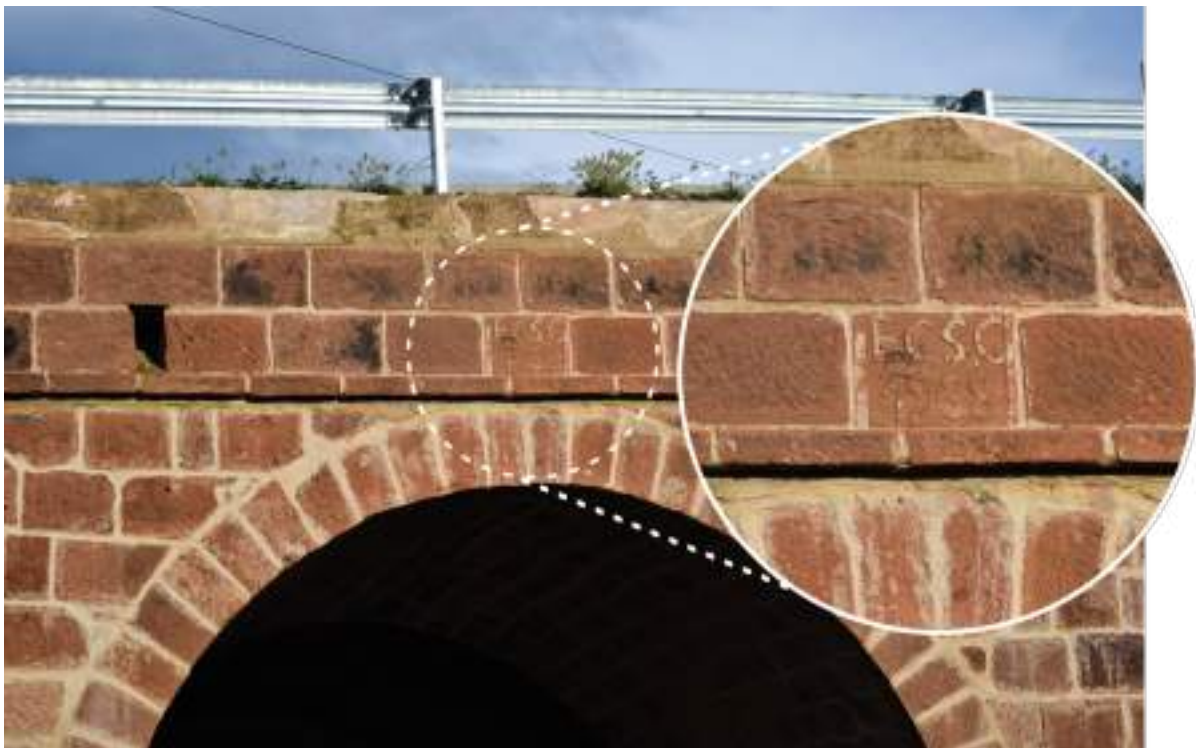
Figura 38 Cara Oeste de la bóveda con el año de construcción original.
