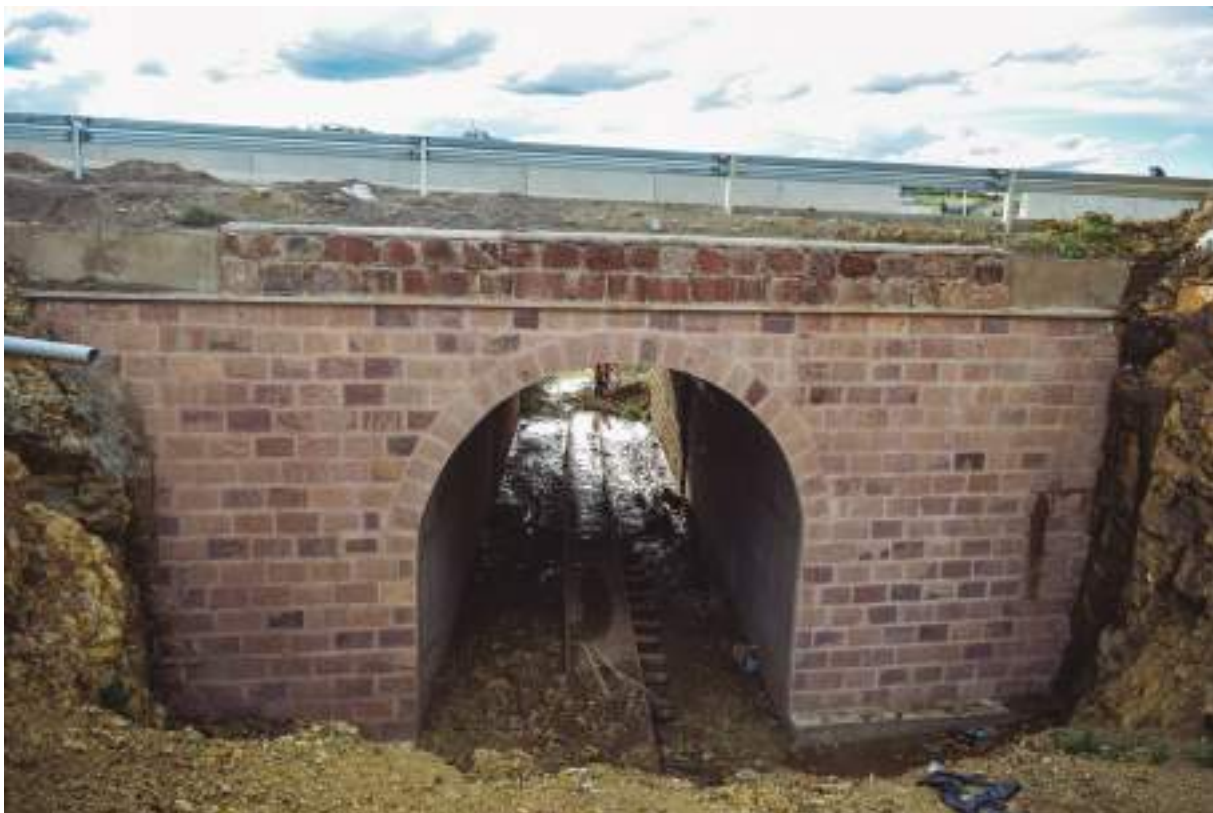
Figura 173 Panorámica luego de la restauración
