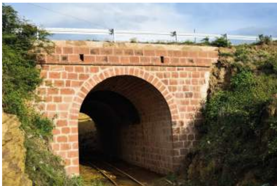
Figura 43 Panorámicas del interior y exterior de la bóveda.
