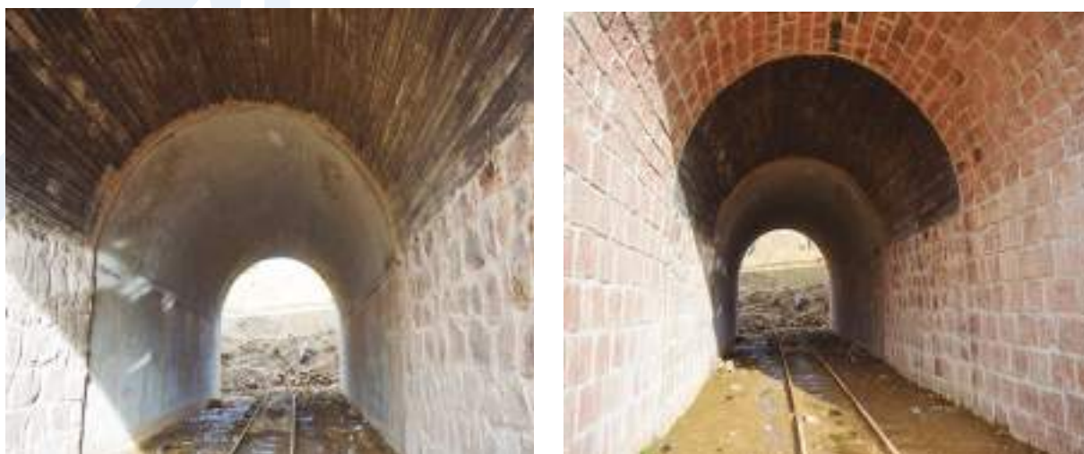
Figura 159 Fotos internas de la ampliación y su sistema constructivo.
